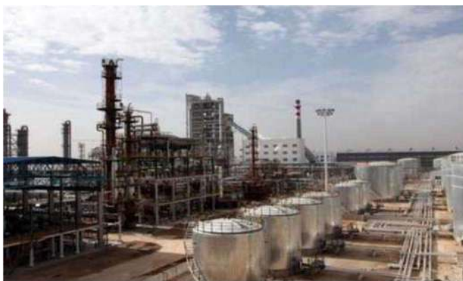
Нефтепереработка, нефтехимия, СПН
