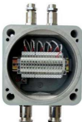
Соединительная коробка термодатчиков (вид внутри)
