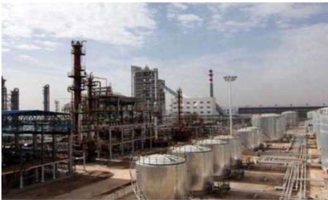
Нефтепереработка, нефтехимия, СПН
