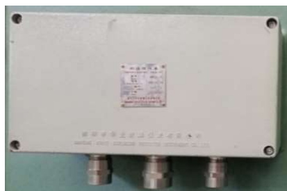
Соединительная коробка термодатчиков
