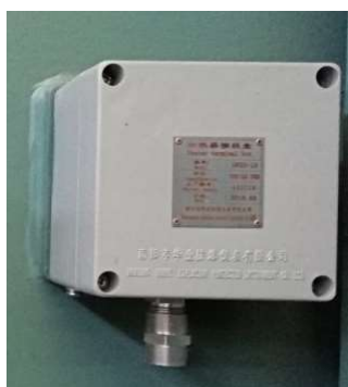
Соединительная коробка обогревателя
