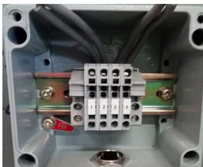
Соединительная коробка обогревателя (вид внутри)
