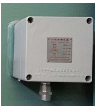
Соединительная коробка обогревателя
