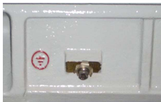
Клемма заземления М12
