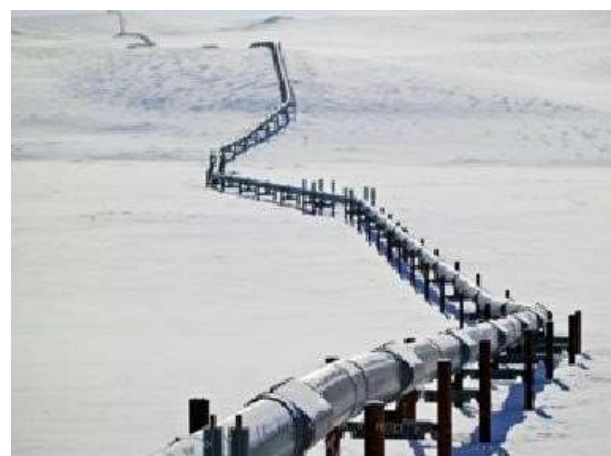
Нефте- и газопроводы
