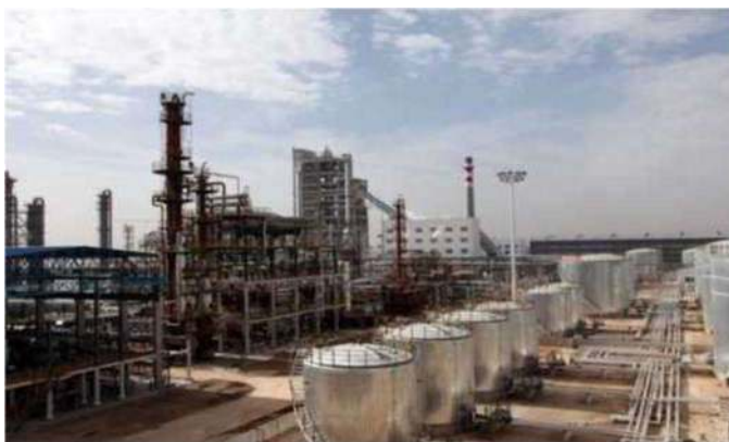
Нефтепереработка, нефтехимия, СПН
