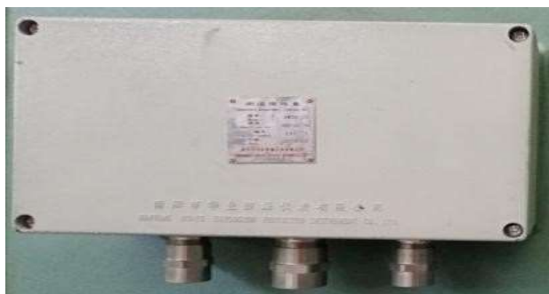
Коробка выводов термодатчиков
