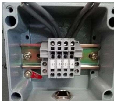
Коробка выводов обогревателя (вид внутри)
