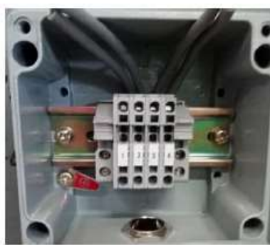
Соединительная коробка обогревателя (вид внутри)
