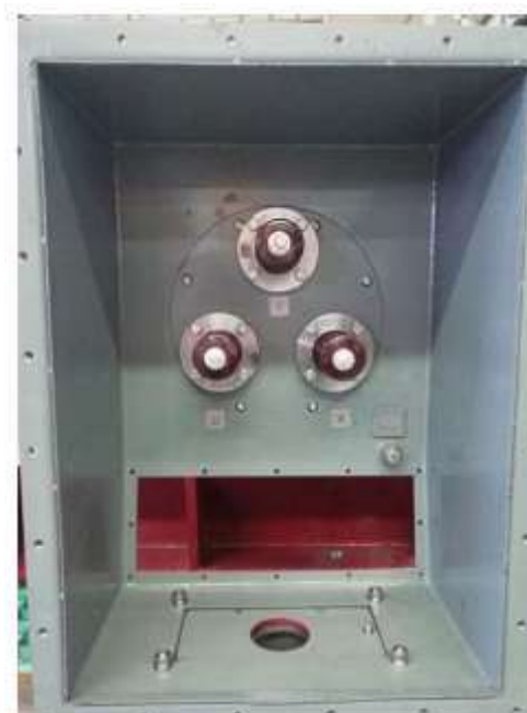
Вид внутри главной коробки выводов
