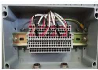
Соединительная коробка термодатчиков (вид внутри)
