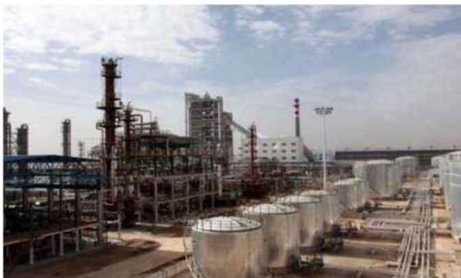
Нефтепереработка, нефтехимия, СПН
